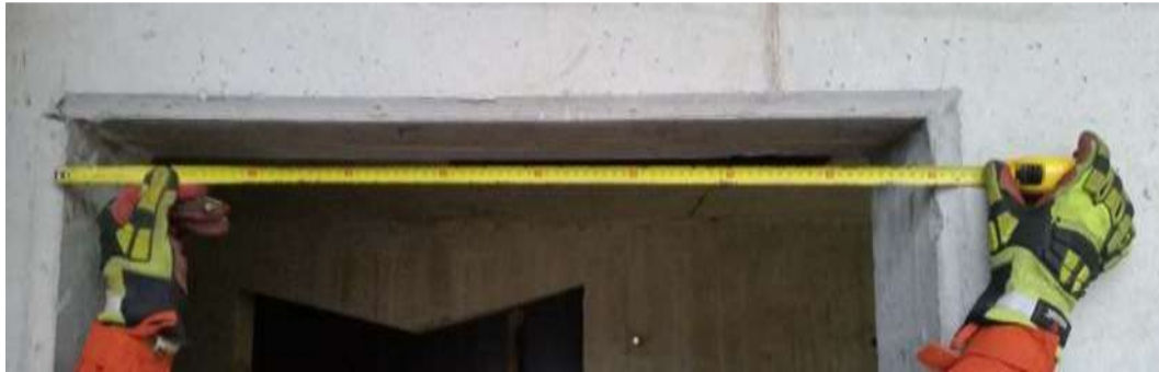
Рис. 46. Вимірювання ширини дверного отвору рулеткою
