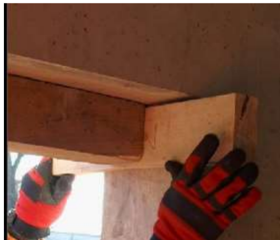
Рис. 47. Розміщення підтяжки та клинів у віконному отворі
